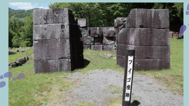
②一番高炉 盛岡城の石垣職人が携わったと言われており、すき間なくピッチリ積み上げられています。
