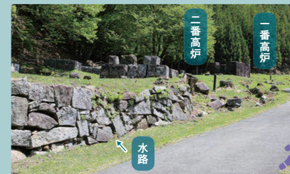
①水路(手前の石垣)に沿って築かれた一番高炉と三番高炉。水車でいごを動かし、風を炉に送りました。
